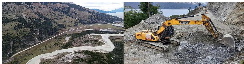
Fotografía N° 26: Camino Vicuña–Yendegaia, Región de Magallanes. Fotografía N° 27: Camino Vicuña–Yendegaia, Región de Magallanes.
