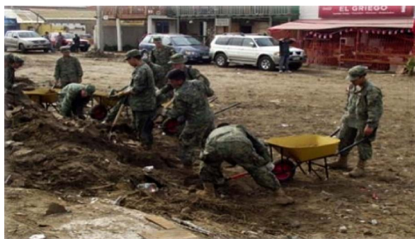
Fotografía N° 3: Limpieza de calles con maquinarias en la ciudad de Concepción, producto del terremoto de 2010.
