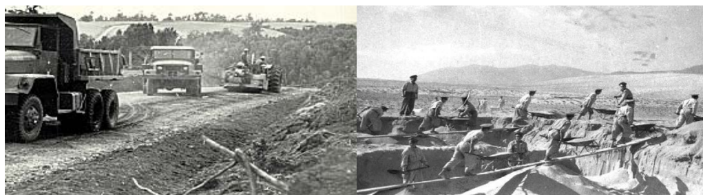
Fotografías N° 1 y N° 2: Obras ejecutadas por el CMT antes de 1976, desde río Palena hacia Puerto Ramírez en la Región de Los Lagos y camino Caldera-Chañaral en la Región de Atacama.
