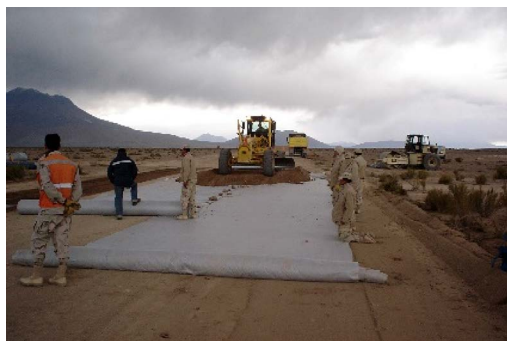
Fotografía N° 8: Construcción camino Parinacota-Visviri, Región de Arica y Parinacota.
